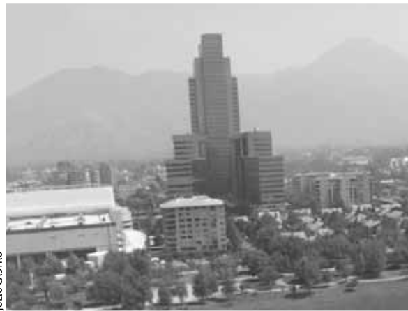
La torre Parque Araucano pasó sin sobresaltos el terremoto debido al sistema de péndulos que incorporó en su diseño.
