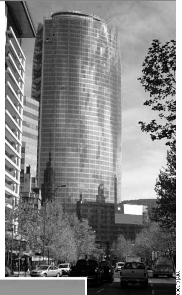
La Torre Titanium La Portada resistió el sismo sin daños importantes que lamentar. Sólo un balcón ornamental se soltó.
