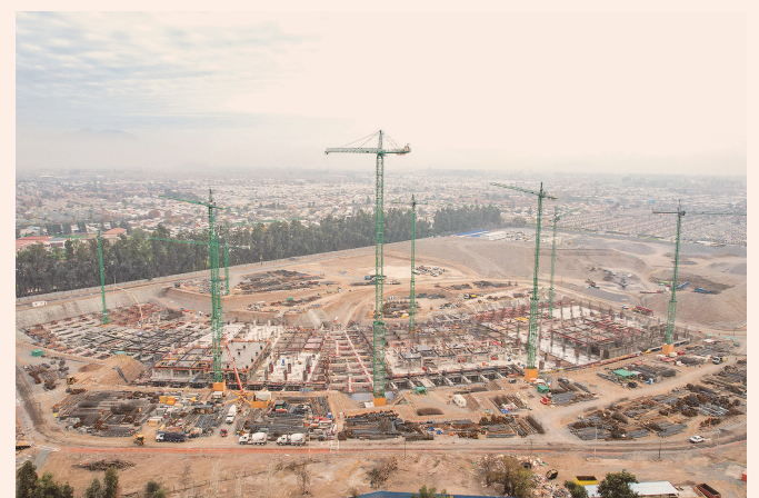
El nuevo Hospital Sótero del Río se encuentra en etapa de construcción.
