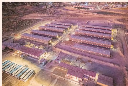
Las soluciones de Tecno Fast generan un bajo impacto en el lugar de instalación, ya que el 90% de la obra se realiza en fábrica.
