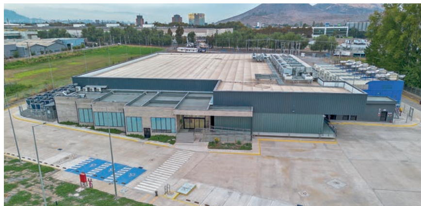
Data Center SAN2, de 20 MW, ubicado en Santiago.
