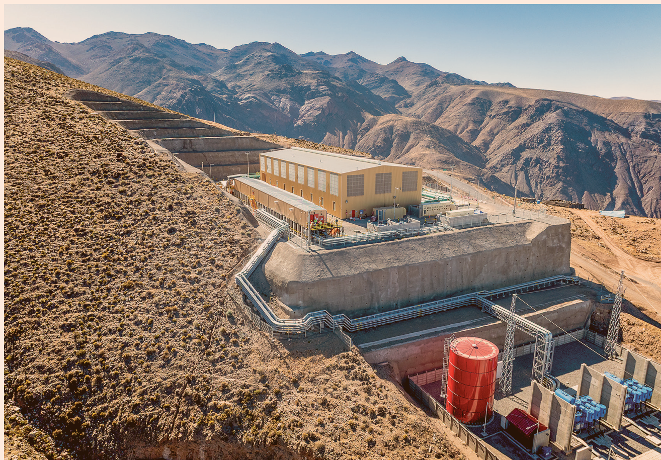
La Estación de Bombeo 5 fue la última estación del sistema de impulsión de agua de mar, a más de 3.750 metros sobre el nivel del mar.
