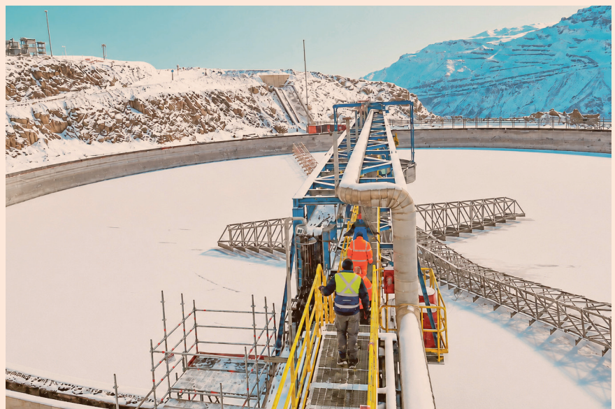
Trabajos de mantenimiento de Ingenalse en el espesador de minera Los Bronces.
